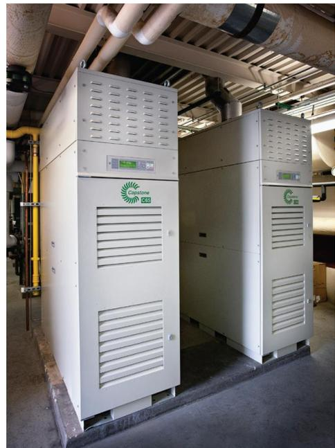
C65 microturbinesCapstone C65 microturbines
